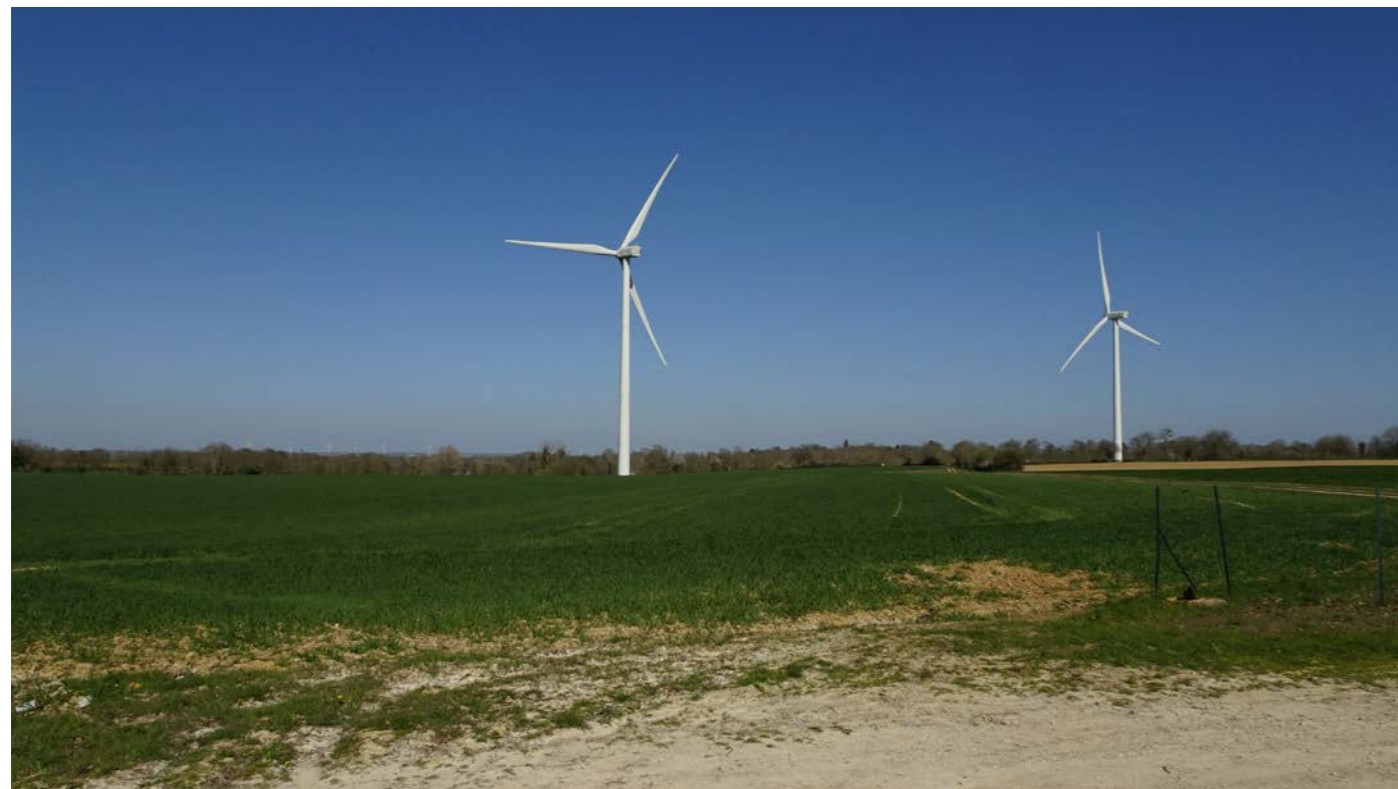
PHOTO 20 : PARC ÉOLIEN DE SOUVIGNÉ
