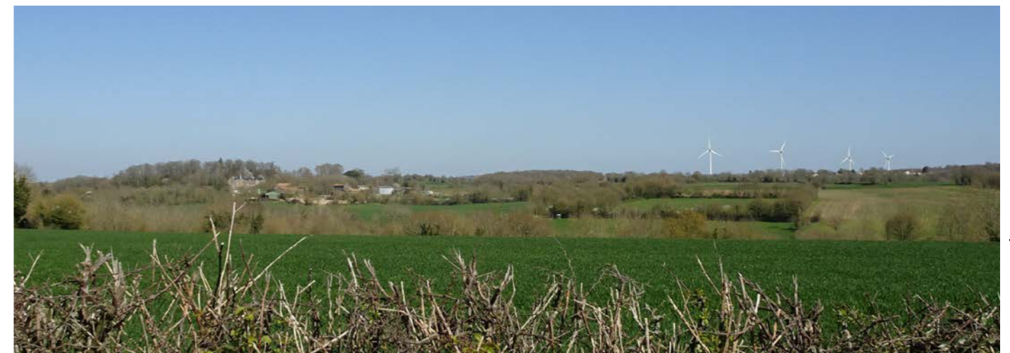
PHOTO 23 : LE PARC ÉOLIEN DE SOUVIGNÉ
